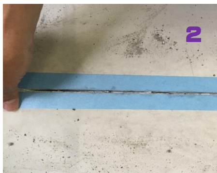
補修面に沿って養生を行います。
