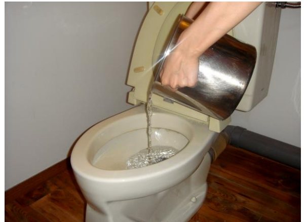
詰まっている箇所に溶液を投入し 30分以上経ったら水を流す
