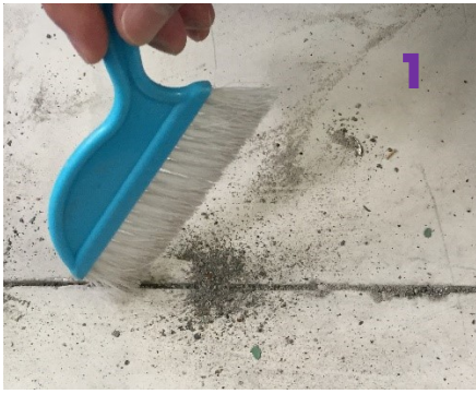
1 補修面の清掃を充分に行います。
