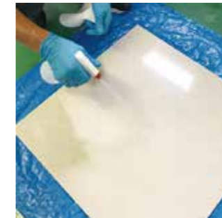
施工面をガソリンで洗浄
