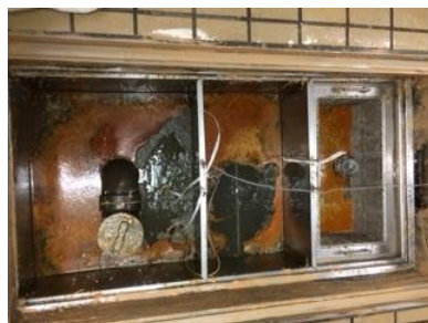
AD バイオペーストを側面にも塗布し消臭膜を形成します。
