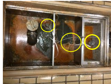
NS バイオボールを各槽にセットし、AD 快適消臭を槽の周り側溝などに適宜に噴霧します。
