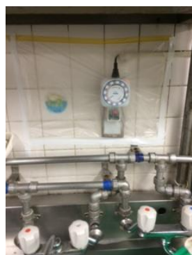
電源の防水養生
