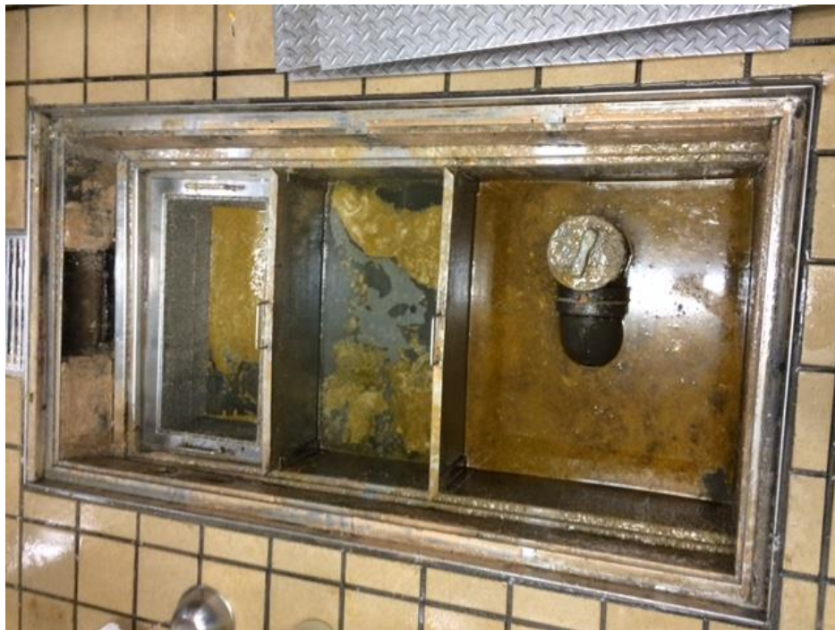
A Dバイオボール、エアー配管、散気設備撤去現状復元
