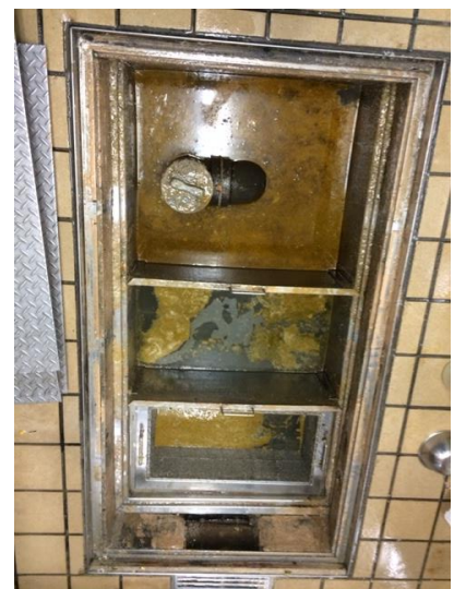
施工後1週間（仮設備撤去事）
