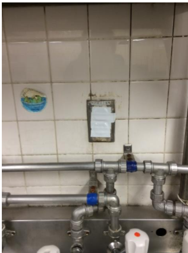
漏電ブレーカー、タイマー撤去原状復元
