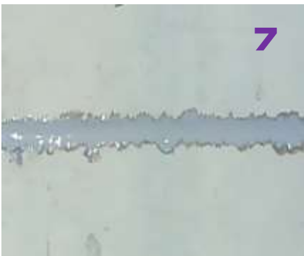
7 硬化を確認して補修完了です。
