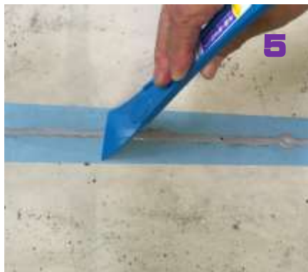
5 充填が終わったら直ちにヘラで余分な材料を除去します。
