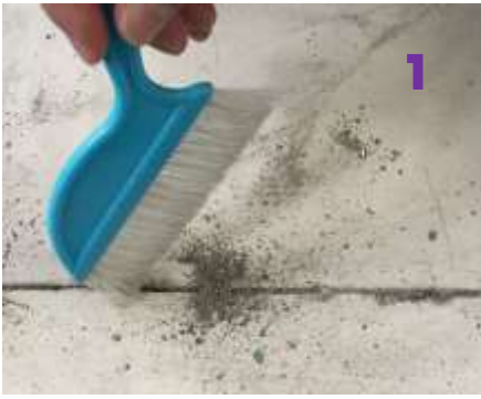
1 補修面の清掃を充分に行います。
