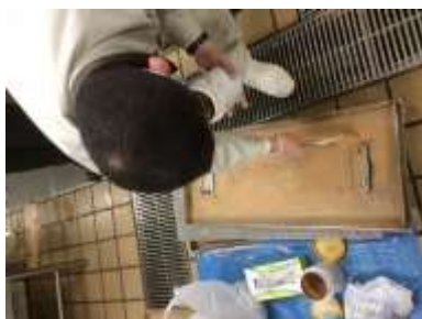
AD バイオペーストを蓋の裏面に塗布し消臭膜を形成します。
