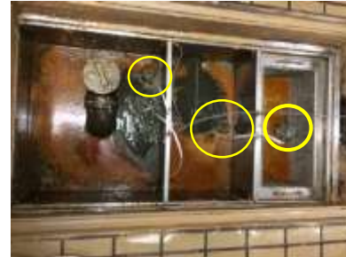
NS バイオボールを各槽にセットし、オールダッシュ快適消臭を槽の周り側溝などに適宜に噴霧します。
