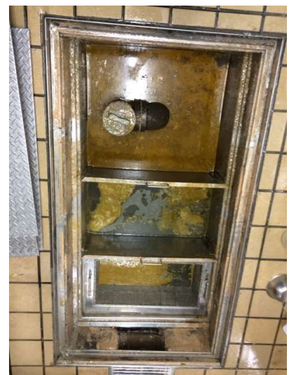
施工後1週間（仮設備撤去事）
